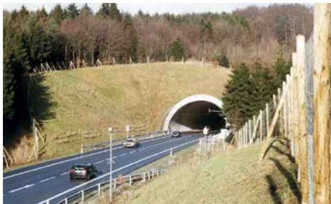
Der 470 Meter lange Tunnel durch den Menkhauser Berg ist Teil der Ortsumgehung von Oerlinghausen. © Straßen.NRW, Regionalniederlassung OWL
